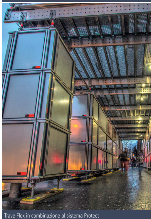
Ampia piattaforma di lavoro sospesa in pochi punti di ancoraggio, priva di controventatura
