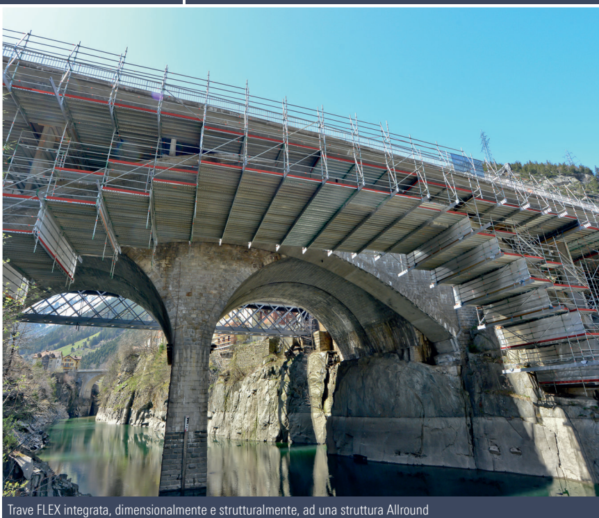
Piattaforma di lavoro in quota, con risparmio di elementi di ponteggio
