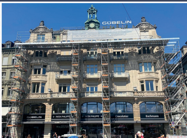
Piattaforma di lavoro in quota, con risparmio di elementi di ponteggio
